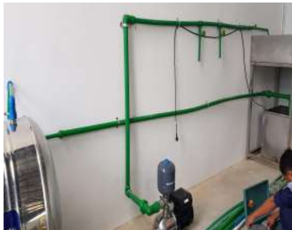
Hạng mục: Lắp đặt hệ thống tuần hoàn nước công ty Manufacturting Company Limited
