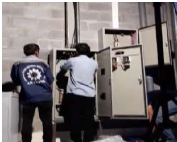
Hạng mục: Lắp đặt hệ thống Điện công ty Japan Việt nam Forging
