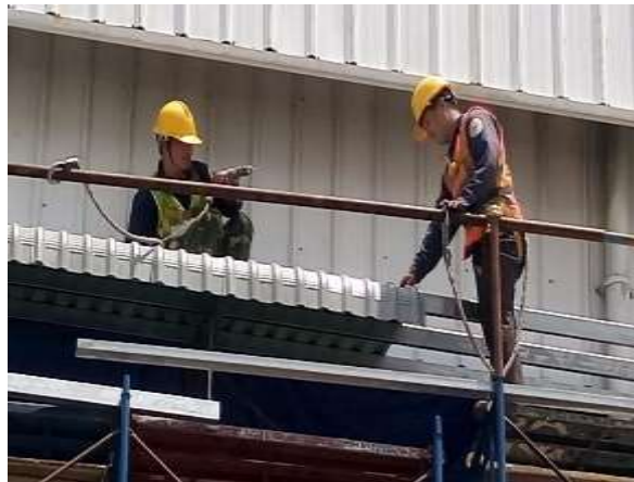
Hạng mục: Thi công mở rộng nhà xưởng công ty DKSH
