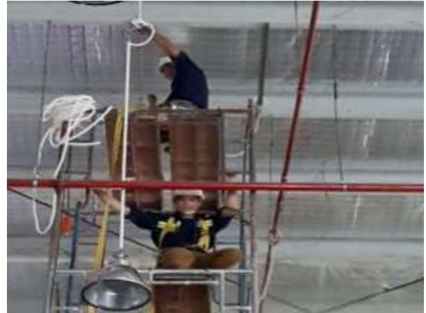
Hạng mục: Lắp đặt hệ thống điện chiếu sáng công ty APPAREL FAR EASTERN
