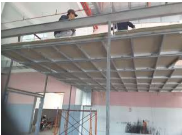
Hạng mục: lắp đặt phòng pha chế mực in công ty Sakata
