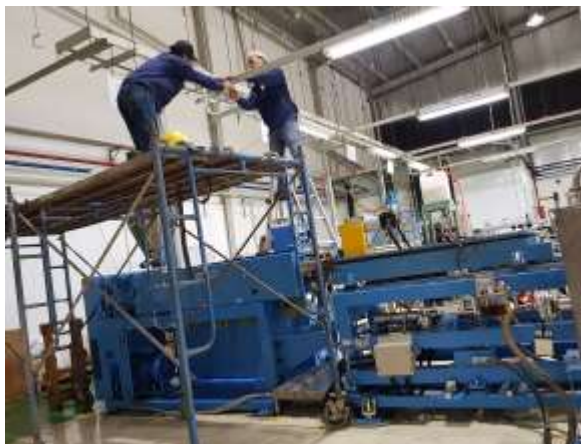
Hạng mục: Lắp đặt hệ thống chiếu sáng công ty Nissei Eco
