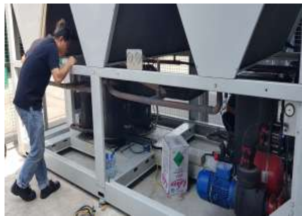
Hạng mục: Bảo Trì hệ thống lạnh công ty Pessico
